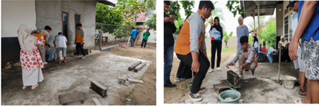
Gambar 2. 4 Pemanfaatan Fly Ash untuk Pembuatan Batako
